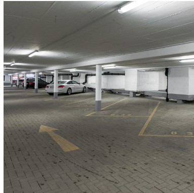
Tiefgaragenebene neu mit Pfahlkopfplatte
